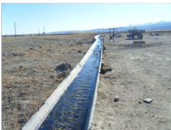
Фото7-23 Состояние периферийной части оросительной системы
