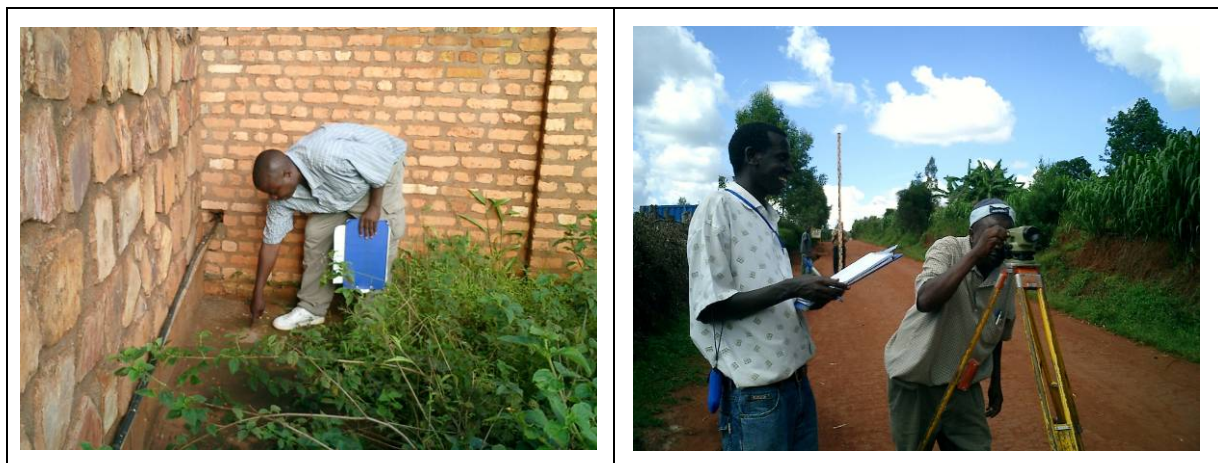
Figure. 9 Scènes de nivellement (à gauche : point de nivellement existant, à droite, nivellement)
