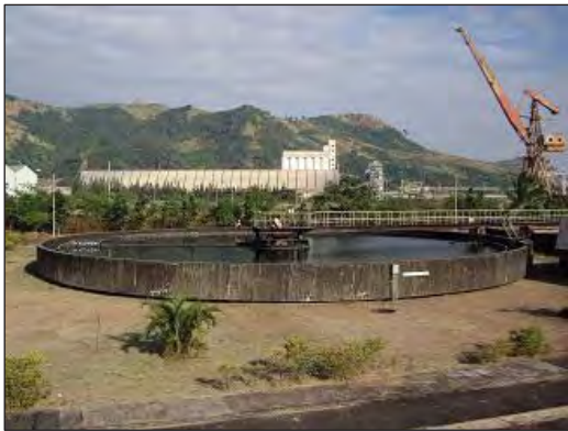
Sedimentation Tank (Bataan)
