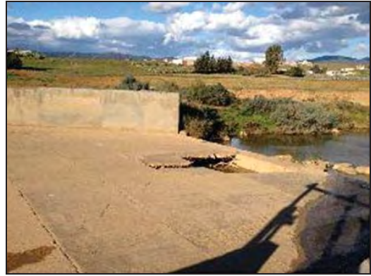
ポンプ場の集水口に生じた亀裂（フェルナナ）
