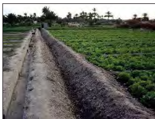
コンクリート水路と古い水路（ガベス）
