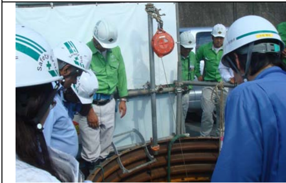
推進工法工事現場視察(2012/9/11)
