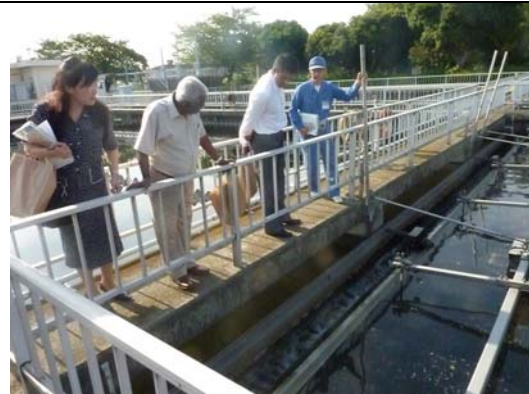
港北水再生センター視察 (2012/9/12)
