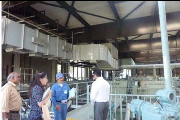
港北水再生センター視察 (2012/9/12)
