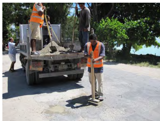
写真 3：道路のメンテナンス作業状況 (本事業対象区間外での状況)
