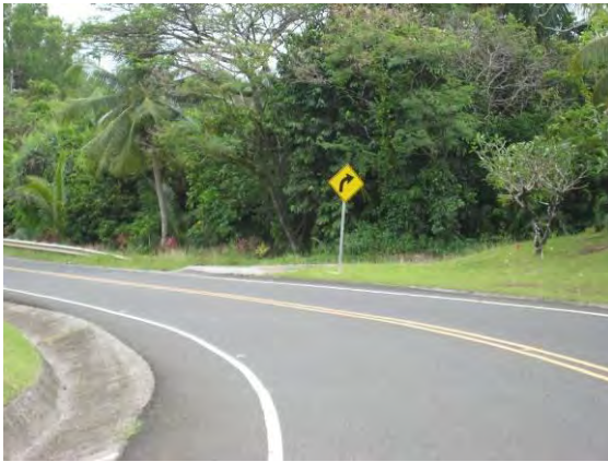
整備された舗装と路面表示（区間 F-1）
