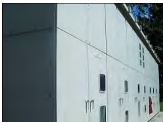
ホニアラ開閉設備
