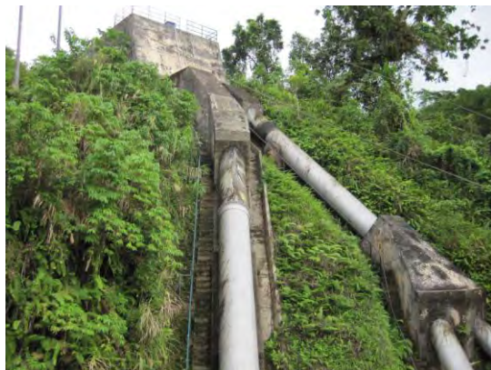
写真 2：敷設された導水管（左側）
