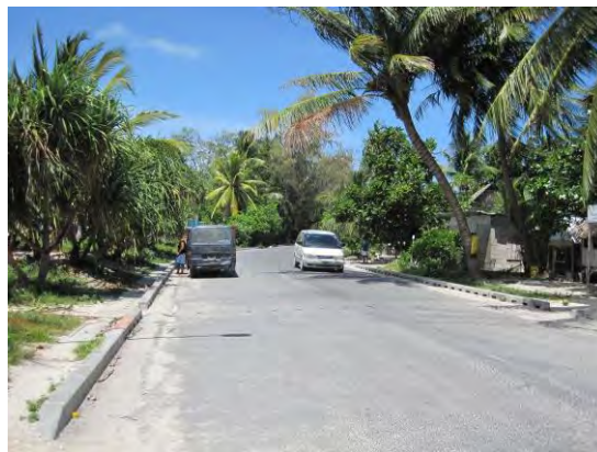
本事業で整備した道路
