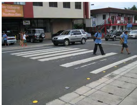
改修後の幹線道路（区間 A：コロール中心部）
