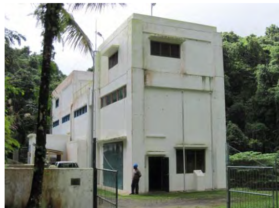
写真 3：水力発電所建屋全景
