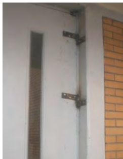
（修理されたドア）
