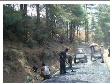
NWFによる道路工事
