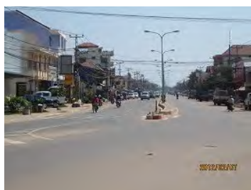
1 号線の始点、シカイ交差点。 照明灯のデザインは住民に好評。
