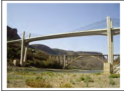
アバイ橋（新橋/手前、旧橋/奥）
