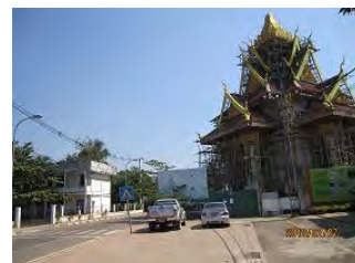
（1号線。工事中の奉納堂前）
