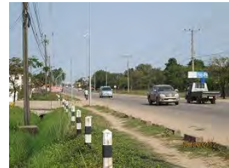
何度か補修された箇所
