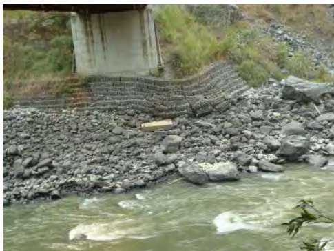
ワクリタル橋護岸（フトン籠工）の沈下
