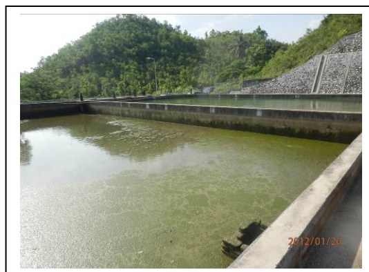
バロンアタス配水池
