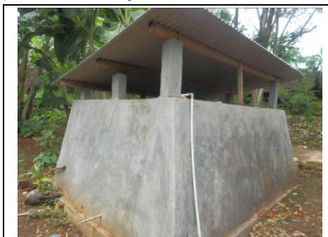
写真 住民が一般的に使用する貯水タンク。パイプでPDAMからの給水を引き込み、天水と水道水を混合し使用している
