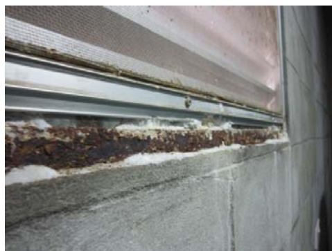
写真:塩分を含んだ風が吹き込み、 塩が析出しているサッシ
