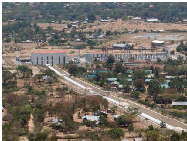
ソンドゥ・ミリウ水力発電所
