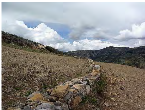
土壌保全工（低速形成テラス、アンカシュ県）
