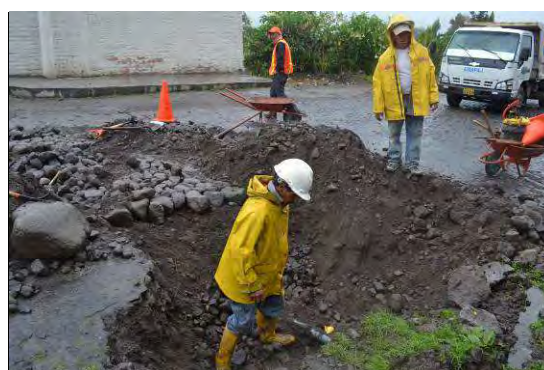
漏水防止工事
