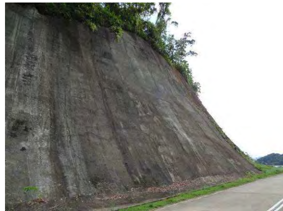
法面工事（タイタイ～エルニド間）
