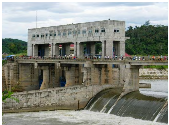
本事業によって完成したバタンハリ頭首工
