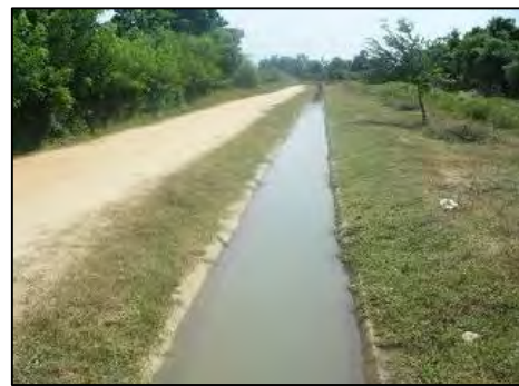
整備された灌漑施設
