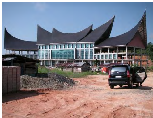
建設中の地域病院
