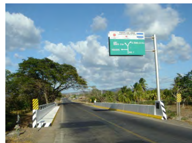
Las Limas Bridge
