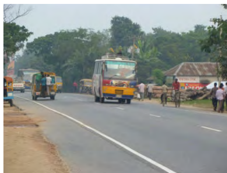
本事業で整備された道路
