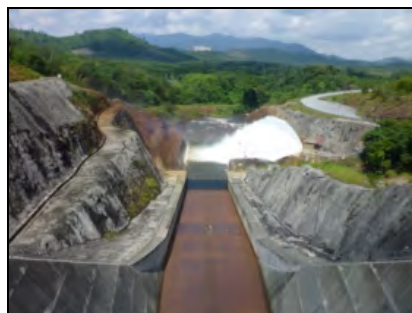
写真 1：余水吐と放水路
