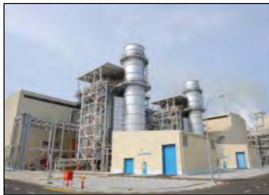
ポートディクソン発電所(本事業発電設備)
