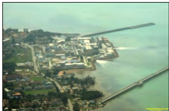
写真 1:ポートディクソン発電所 全景
