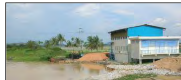
写真2：ペナン州水道公社 のムダ川からの 取水ポンプハウス
