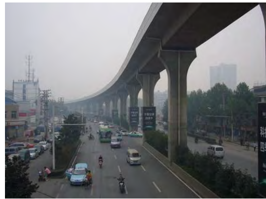
高架部軌道（京漢大道）
