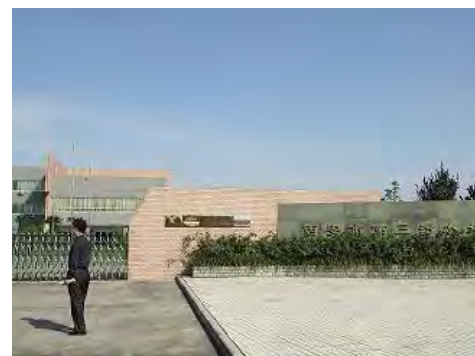
西安市第3下水処理場
