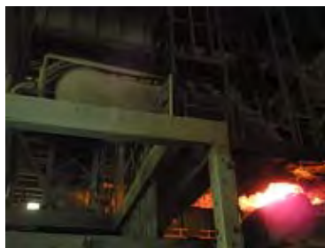
AOD 製錬炉及び集塵設備
