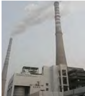
重慶九龍電力西工場全貌
