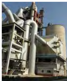
キルン出口の電気集塵機（右四角部分）
