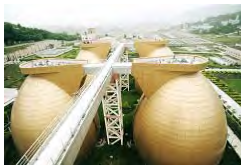
鶏冠石下水処理場消化池
