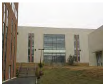
新工場 国際製造部門
