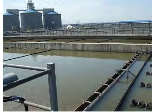
第 4 下水処理場
