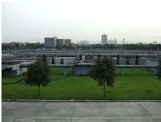
第 3 下水処理場
