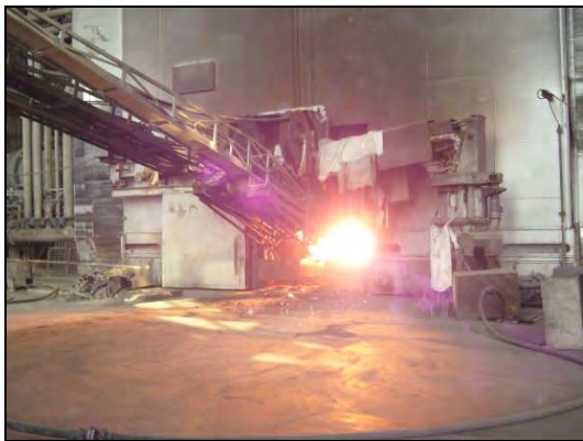
電炉環境改善対策
