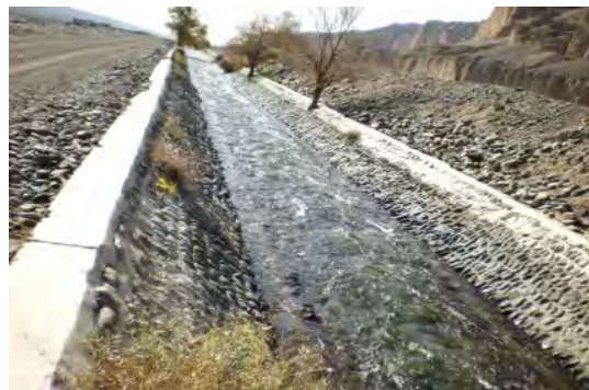
幹線水路（トルファン）
