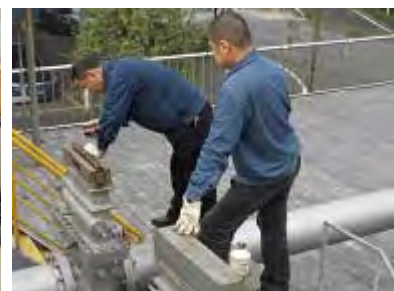
同ステーションの点検中職員
