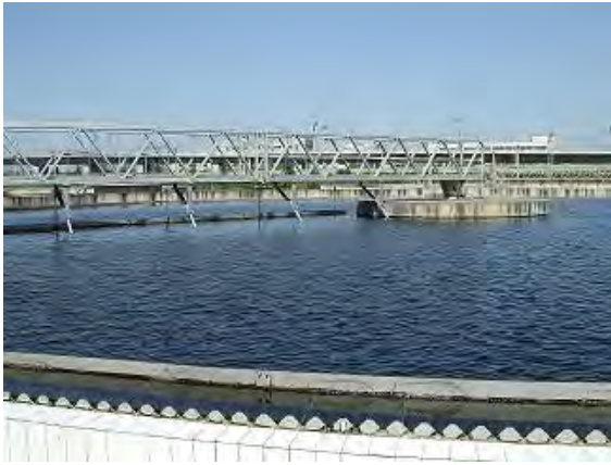
第 4 下水処理場
