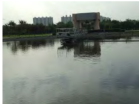
第 3 下水処理場
