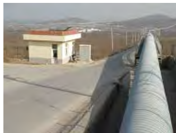
石灰石用ベルトコンベヤー
