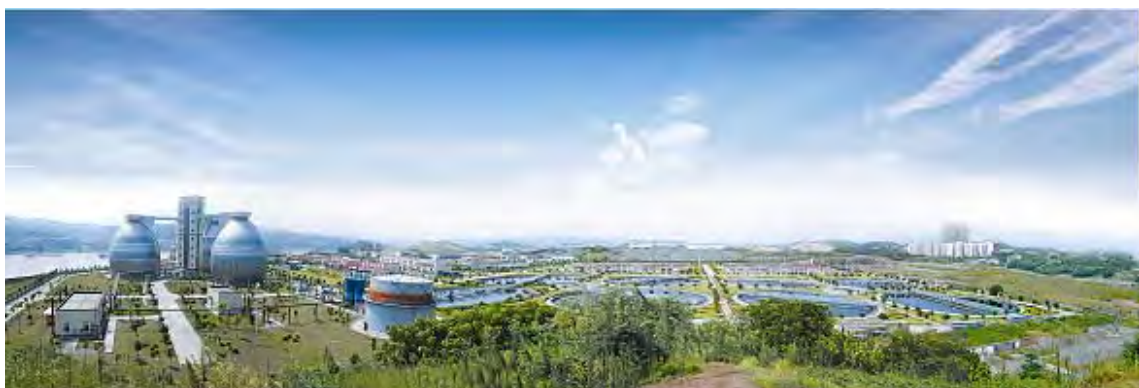
唐家沱污水处理場（左奥が長江、左の卵型設備が消化池、右が沈殿池、生物反応池等） 写真提供：重慶排水公司
