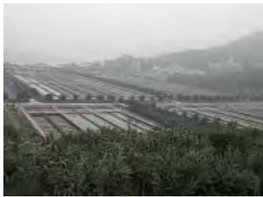
沈殿池と生物反応池全景
