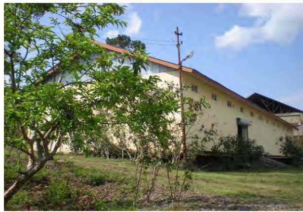
図 14 ビシュヌプール郡の倉庫
