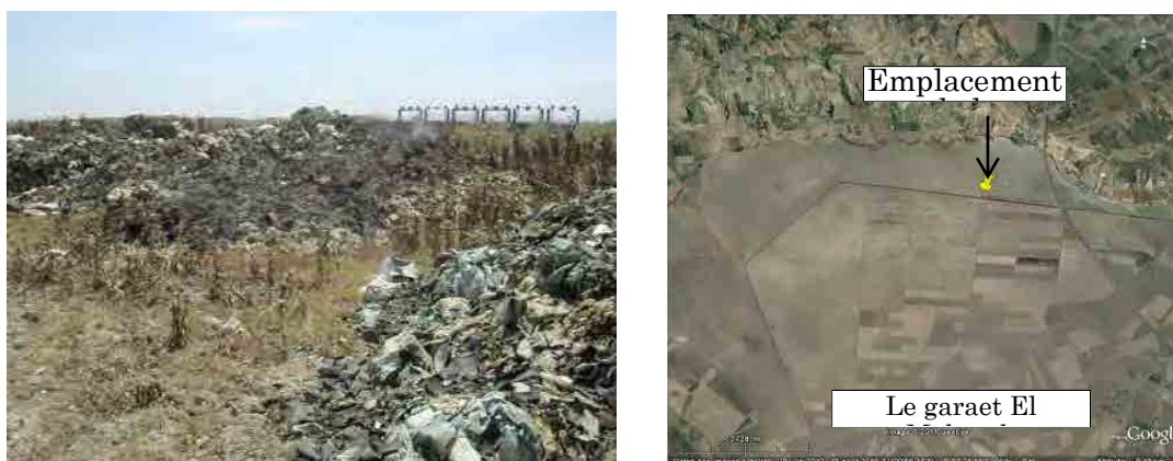
Figure 18 Décharge sauvage de déchets industriels dans le garaet El Mabtough, dans la zone d'emprise du projet
