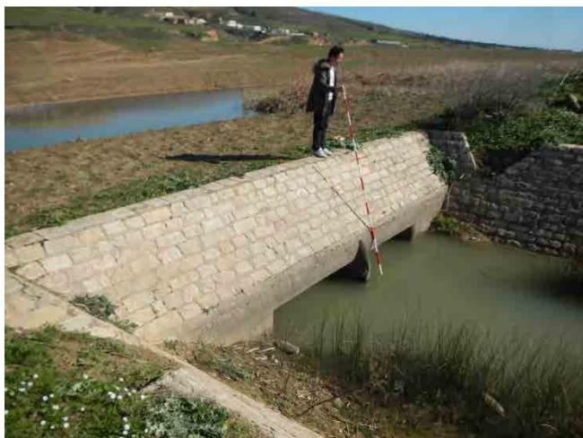
Lors la taille des écluses est importante, on met en place des dalots. Il n'existe pas de vanne sur la sortie, mais il faudra considérer de modifier le système en écluse lors de la réhabilitation.
