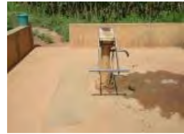
【給水施設周り】
