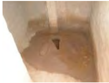
【家庭用トイレ内部】
