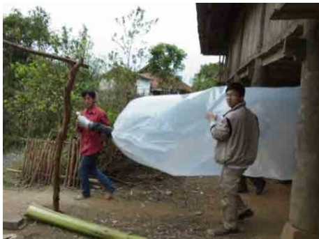
Sau khi đã thổi không khí vào túi nhựa (túi nhựa PE), túi PE được chuyển và đặt vào một cái hố đã được chuẩn bị trước.
