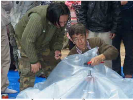
Tạo ra một lỗ nhỏ để lắp van dẫn khí gas ra ngoài (ảnh trên bên trái). Lắp đặt một ống để đưa phân vào bể và một ống để đưa nước thải ra ngoài (ảnh trên bên phải)
