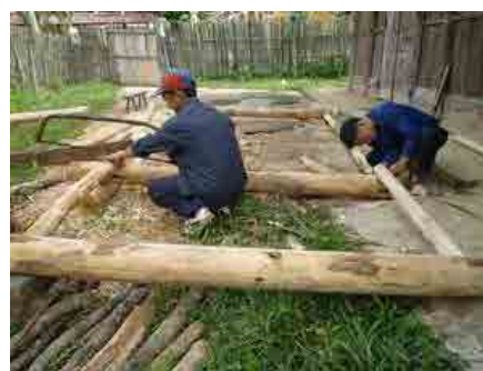
Ảnh 2-15: Công trình xây dựng khu sản xuất rượu đã được bắt đầu (Bắt đầu tháng 12 năm 2012)
