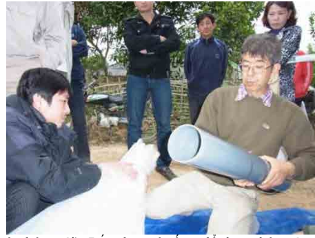
Tạo ra một lỗ nhỏ để lắp van dẫn khí gas ra ngoài (ảnh trên bên trái). Lắp đặt một ống để đưa phân vào bể và một ống để đưa nước thải ra ngoài (ảnh trên bên phải)
