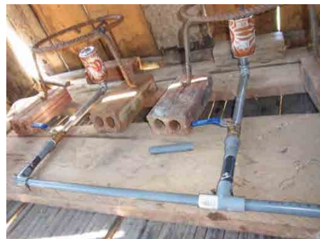
Ống cung cấp khí gas được nối với van dẫn khí gas (ảnh trên bên trái). Việc lắp đặt bếp đun bên trong nhà bếp (ảnh trên bên phải)
