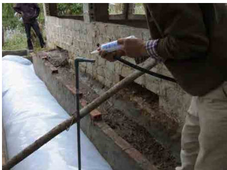
Ống cung cấp khí gas được nối với van dẫn khí gas (ảnh trên bên trái). Việc lắp đặt bếp đun bên trong nhà bếp (ảnh trên bên phải)
