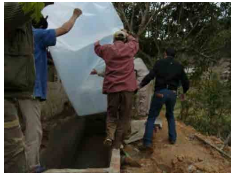
Sau khi đã thổi không khí vào túi nhựa (túi nhựa PE), túi PE được chuyển và đặt vào một cái hố đã được chuẩn bị trước.
