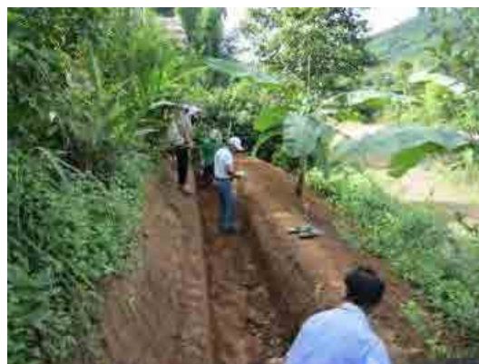
Ảnh 2-10: Tập huấn về lắp đặt công trình khí sinh học bằng nhựa tại bản Nà Phát A
