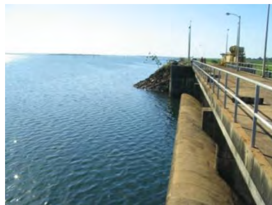
イグアスダム貯水池左岸状況：
