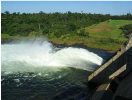
イグアスダム直下・放流状況： ANDEはダム近傍の原生林を保護林として SEAMに申請中である。
