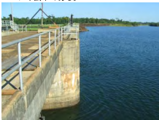
イグアスダム貯水池右岸状況： ダム直上における堆砂は1.6mほどである。
