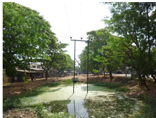
先変電所の電源となる 33kV 配電線。 電線サイズは細く、配電線の老朽化も著しい
