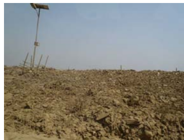
太陽電池外灯と竹製ガス抜き管
