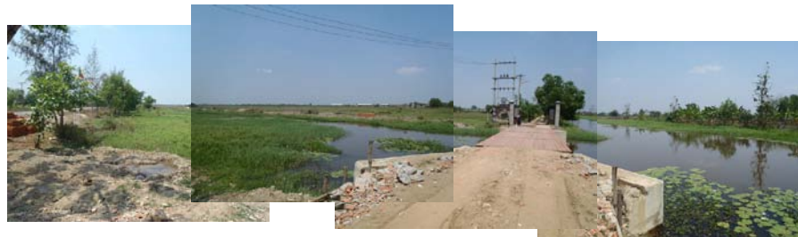
Maso 処分場候補地概観
