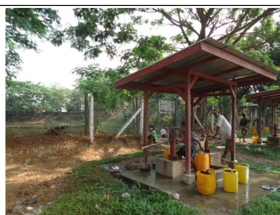
隣の貯水池から汲み上げるポンプ
