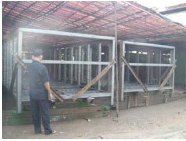
コンテナ (800ft 2 =25m 3 ) 骨組み (工期 : 約 10 日、製作費 : 約 400 万 kyat/基)
