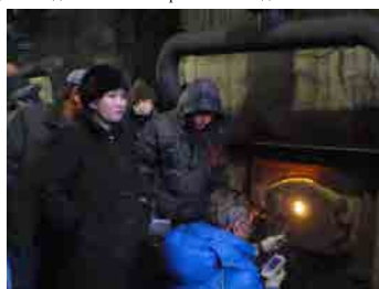
Зуухны бүтээмжийн хэмжилтийн байдал
