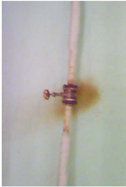
Зураг 5-2-5 Үйлдвэрлэлийн эцсийн дамжлагын ерөөний дулаалаггүй хавхлагууд болон дулаалгыг бүрэн байдлаар хийгээгүй хэсгүүд
