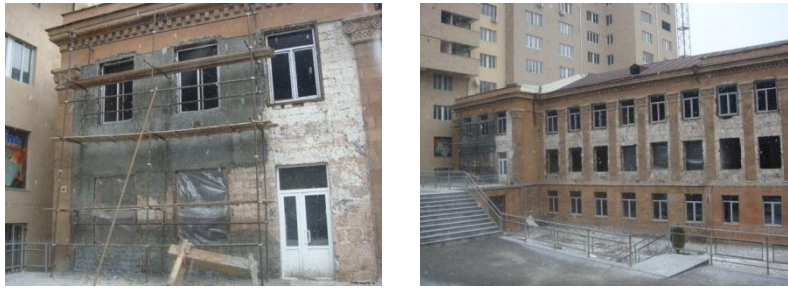
Դպրոցի շենքի ամրացում (Շաղախով և ամրանային ցանցով քարե պատերի երեսպատում), Կենտրոն թիվ 29 դպրոց
