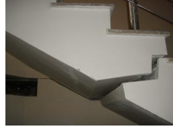
ե) Մեկուսիչներ 2-րդ հարկի սյան վերին մասում գ) Աստիճանավանդակ՝ մեկուսիչների հետ նույն մակարդակի վրա
