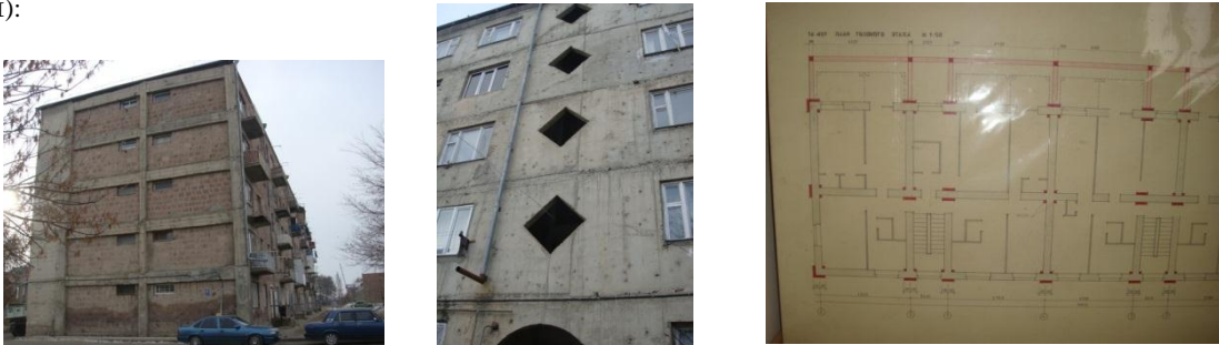
Նկար 6.1-3 Վնասված քարե շենքի ամրացում (1-451 սերիա),
