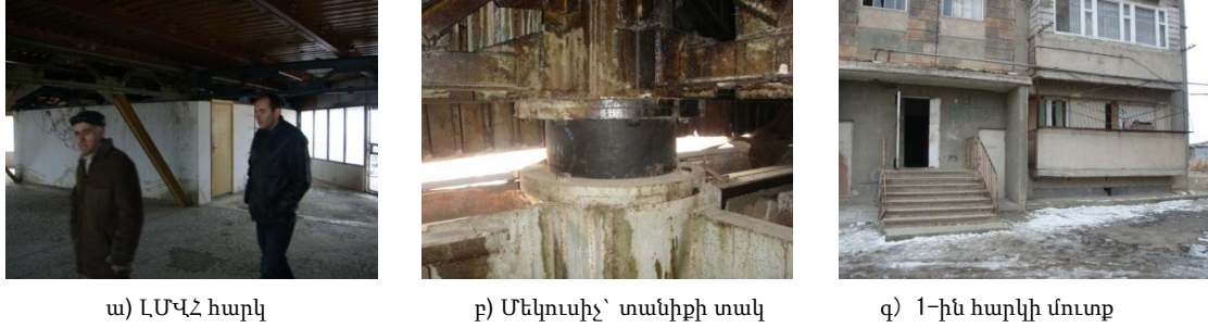
Նկար 6.1-6 Տանիքում զանգվածային կարգաբերվող մարիչով (ԼՄՎՀ) ամրացում՝ շրջանակապանելային (111 սերիա) շենքի համար
