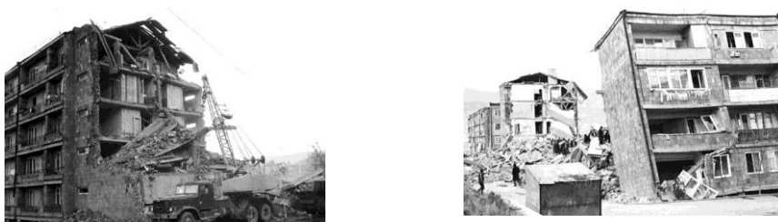
(ա) Կողային հատվածի փլուզումը Գյումրիում (ՄՊԱԾ ԿՄԿ) (բ) Կենտրոնական հատվածի փլուզումը Գյումրիում (ՄՊԱԾ ԿՄԿ)
