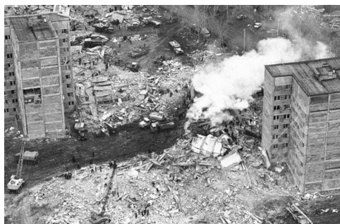
(ա) Շրջանակապանելային շենքի փլուզումը Գյումրիում (ՍԳԱԾ ԿՍԿ)
