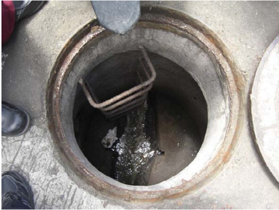
Bagian dalam manhole eksisting.
