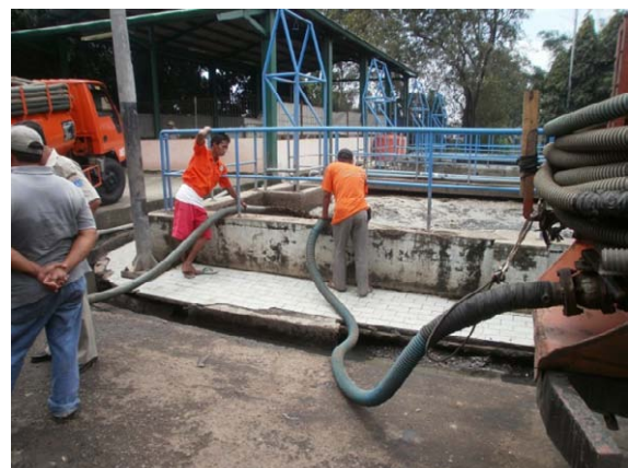
Lumpur On-site dibuang ketangki penerima pada instalasi pengolahan lumpur eksisting.
