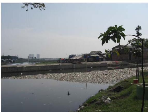
Kondisi limbah padat terakumulasi di waduk Pluit.
