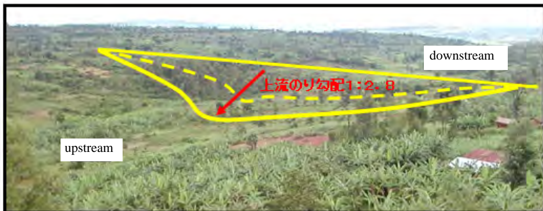
Figure 2.1.51 Image du corps du barrage achevé
