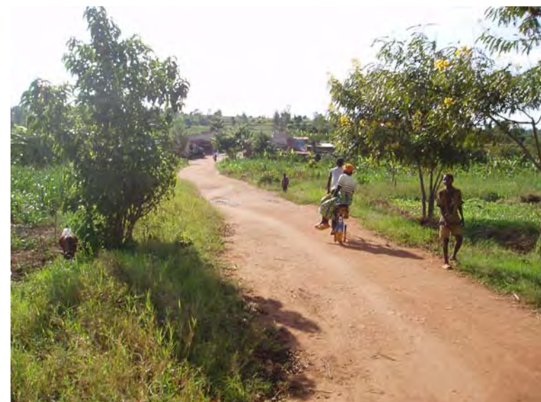
Bugesera2 Route de village en aval. Le côté gauche est le côté en amont. Il n'y a pas de canal de drainage. La route est inondée plusieurs fois par an. Le Lac Rumira se trouve à environ 200m du côté droit.
