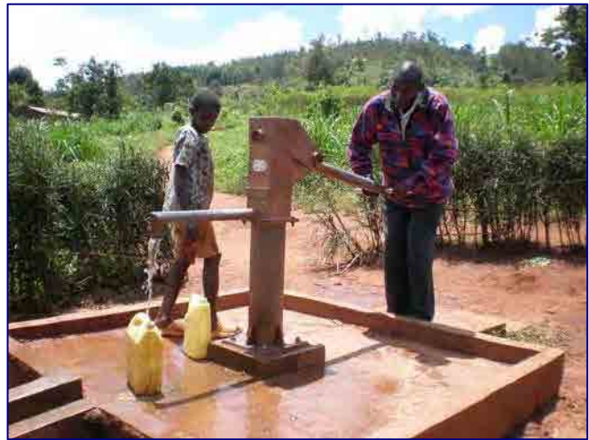
No. 14 深井戸ハンドポンプ
