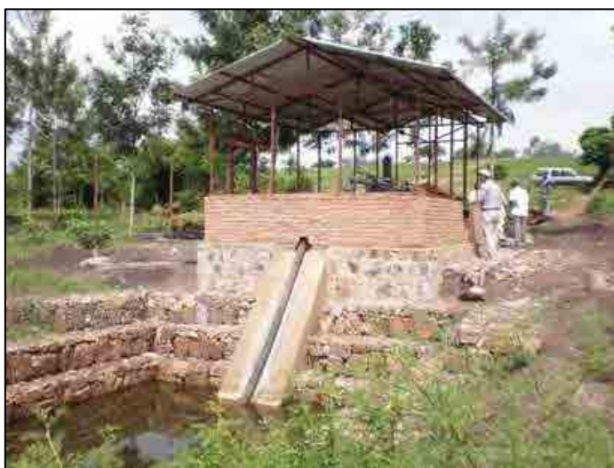
Rumira 湖から揚水して斜面の畑にスプリンクラーを用いて灌漑する（Lux-Development による事業）
