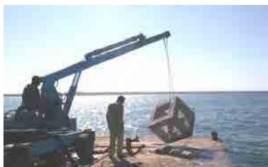
写真Ⅱ-13：漁民による蛸集増殖型人工魚礁の製作、DGPAによる沈設作業
