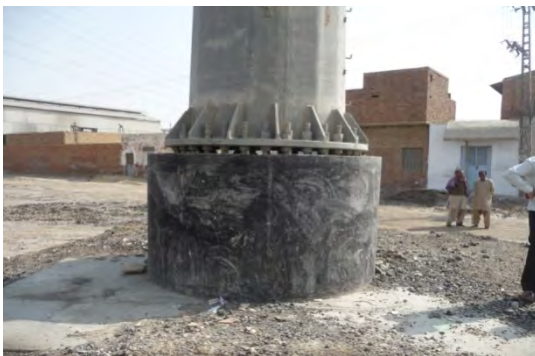
ジャムショロ〜ハイデラバード送電鉄塔基礎
