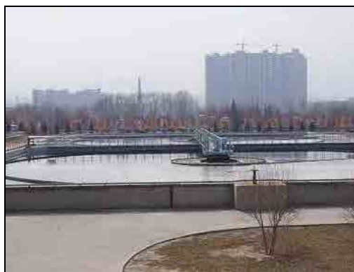
汚水処理場(最終沈殿池)
