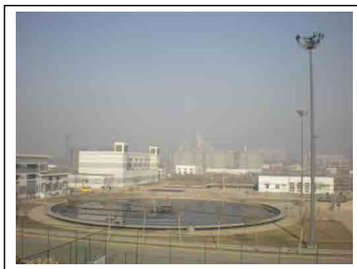
咸陽路污水处理場
