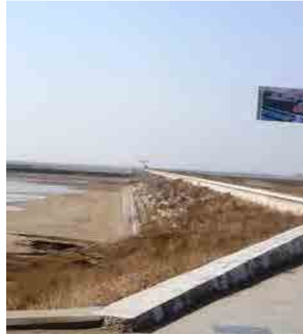
図3 下鎮地区の堤防
