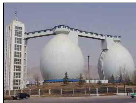
図 13 汚泥処理施設
