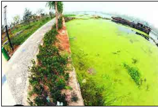
図 1 事業実施前の水路の状態
