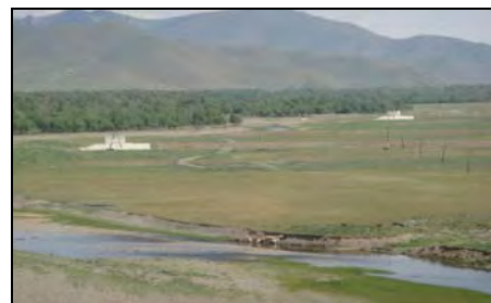
トーラ川沿いの取水井戸 (全 16 井)
