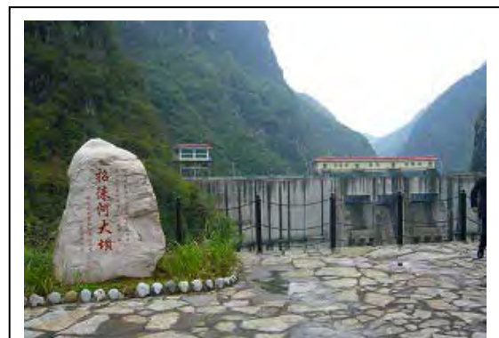
長陽サブプロジェクト発電所
