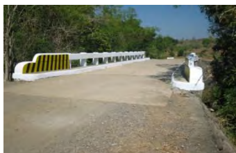
図 7 建設された農道—橋梁
