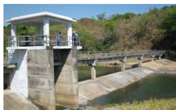
整備された灌漑施設 - 取水堰
