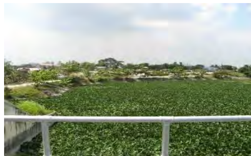
図2 本事業で整備された調整池に繁茂する水草（布袋葵）
