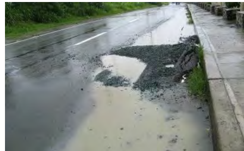
図3 本事業で建設された管理用道路
