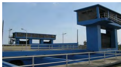
本事業で建設された排水機場
