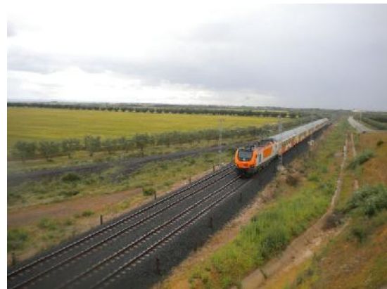
複線化された軌道および走行中の旅客列車
