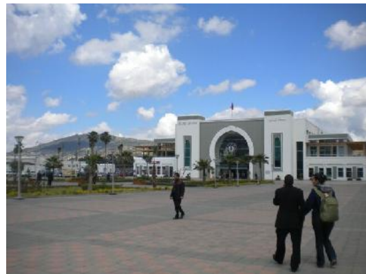
フェズ駅舎と駅前広場
