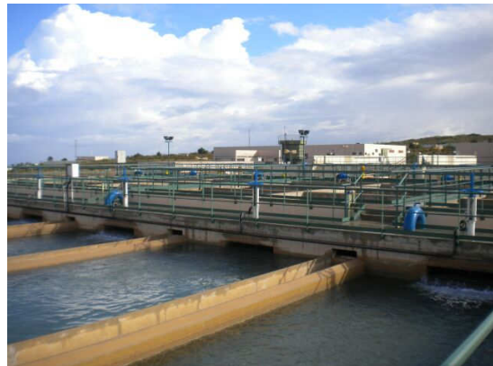
建設されたタムリ浄水場
