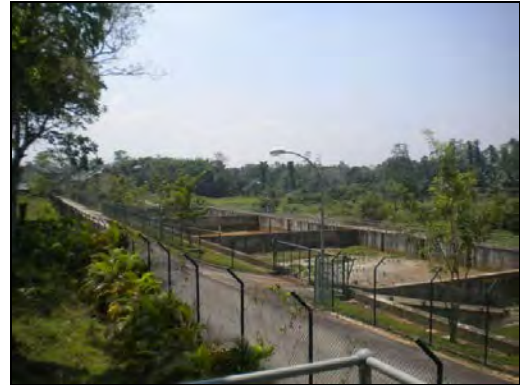
汚泥処理施設
