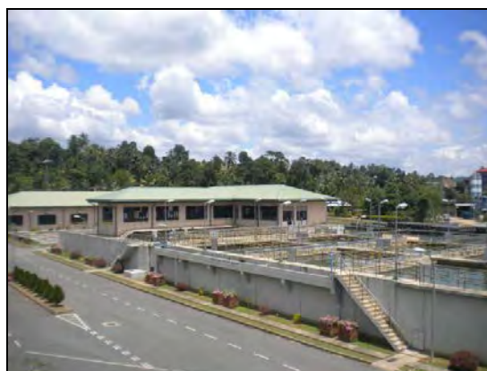
カツガスタタ浄水場全景
