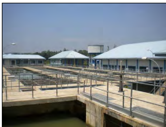
本事業により新設された浄水場
