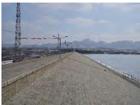
龍口市王屋ダム（改修工事）
