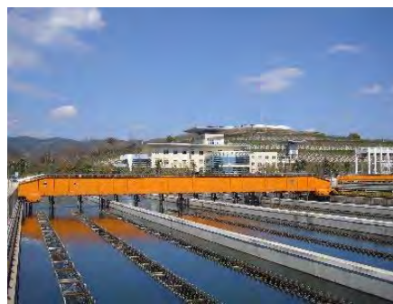
第7浄水場（沈殿池及び事務所棟）
