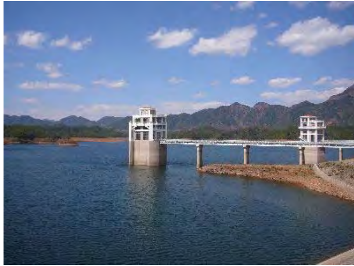
雲龍ダム（貯水池及び取水塔）
