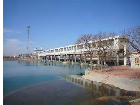
菜州市地下ダム（新設工事）
