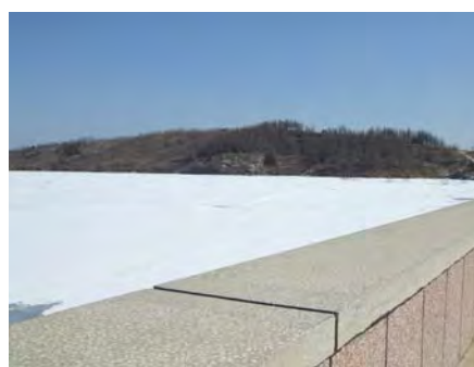
庄河上水の取水地 朱隈ダム
