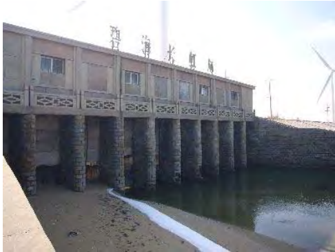
菜州市丁子堤（新設工事）
