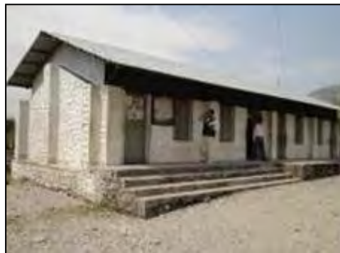
本事業で建設された教室 (マクワンプール (Makawanpur) 郡)
