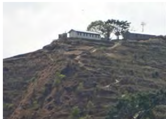
写真 5 急峻な尾根に位置する学校に本事業で建てられた教室
