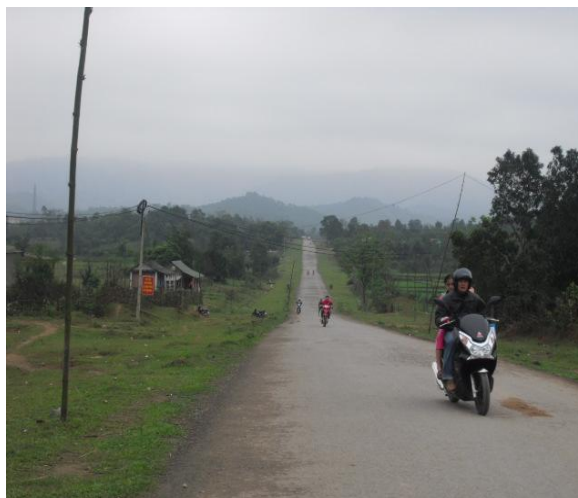
本事業により新規敷設されたクワン・チ省の 省道を通行するオートバイや自転車の利用者
