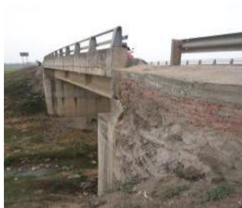
図4 仮設橋の斜面の状況
