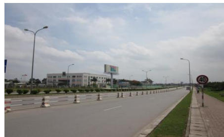
図 2 タンロン工業団地前の道路
