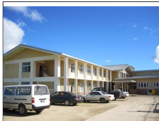
本事業で整備した病棟
