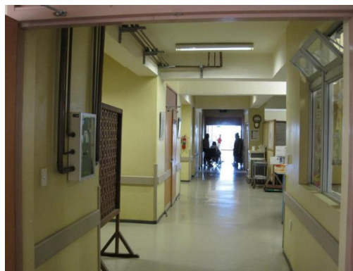
写真2：外科病棟内部
