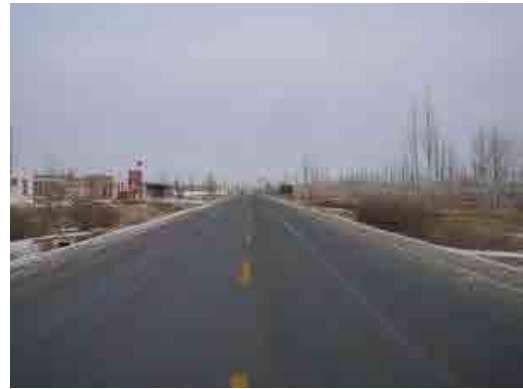
景泰—西槽道路 始点地点（西槽）
