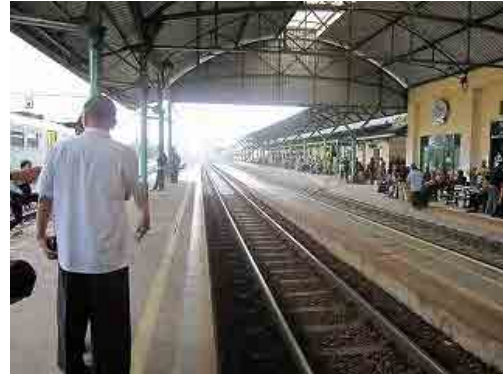
本事業で整備したクトアルジョ駅
