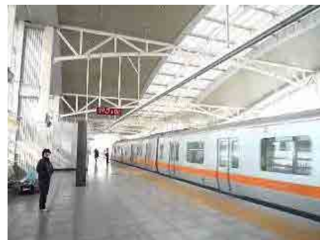
立水橋駅ホームの様子
