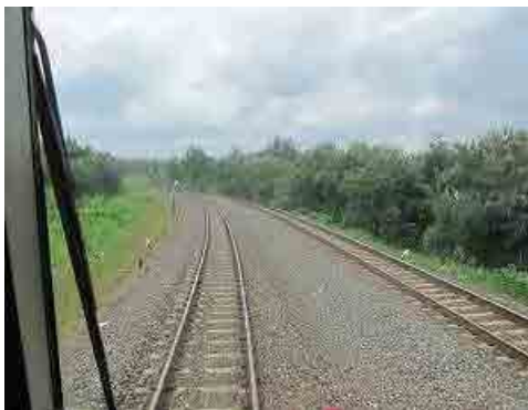
修復された在来線軌道（右）と 新設軌道
