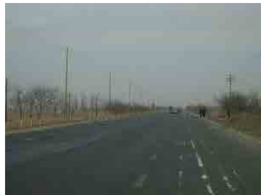
景泰－西槽道路 終点地点（景泰）
