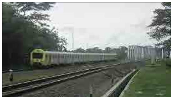
新設軌道・鉄橋を走る近郊列車
