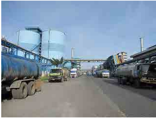
敷地内のパーム油企業エリア
