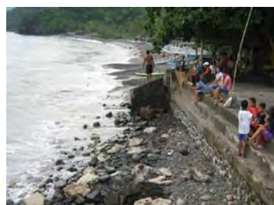
図 19 海岸保全対策未実施の海岸② (バリ島東部ブイタン海岸)
