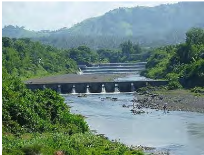
図 20 バリ島最大河川（ウンダ川）の砂防ダム
