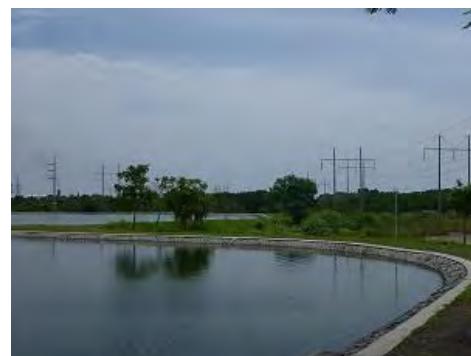
下水処理場・安定化池
