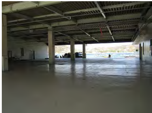
稼働率の低い荷捌き場
