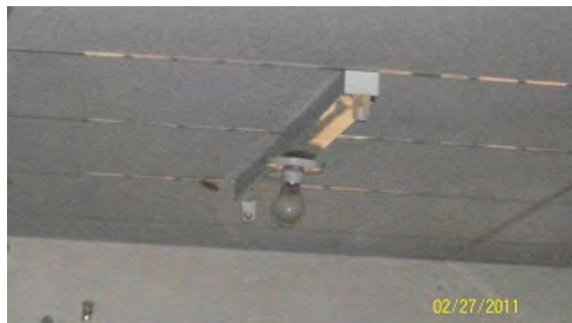
蛍光灯が外れ、より安価な電球で代替されている(マナグア市 Diriangén 校)。他の学校でも多く見られた対応。
