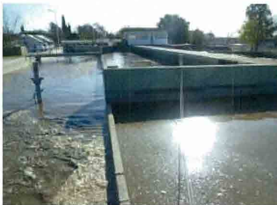
写真1 Hurlingham 処理場施設
