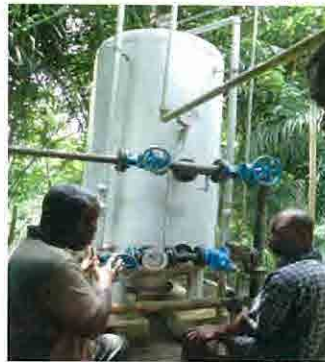
写真4: ヴビイ/ディグへの砂ろ過器
