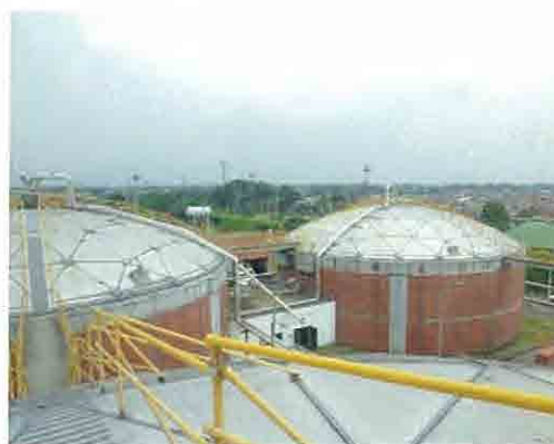
下水処理場全景
