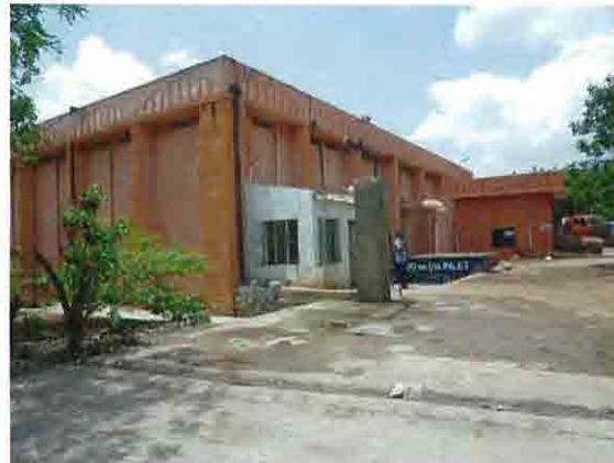
写真 ハイデラバードの上水道施設
