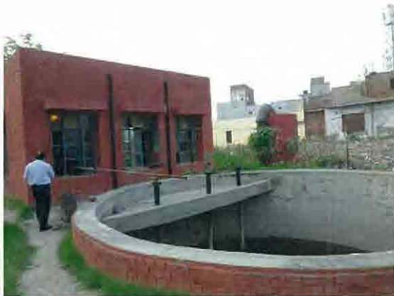
写真 アムリトサルの排水施設
