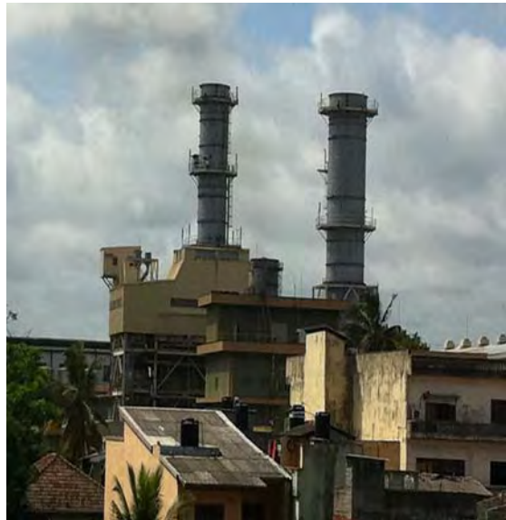
ケラニティッサ・コンバインドサイクル発電所
