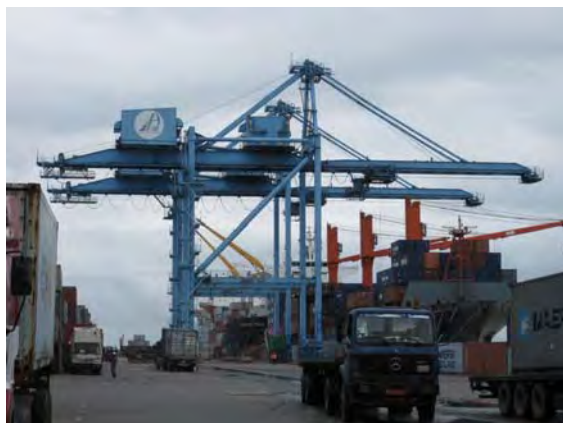
稼働中のガントリークレーン
