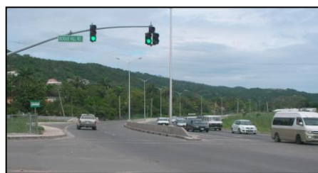
写真-5 4車線化された道路の状況
