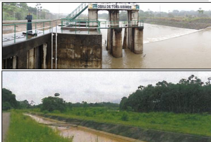
上段：シビンベ頭首工/下段：シビンベ地区幹線用水路
