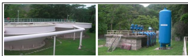
写真-4 グレートリバー浄水場の様子
