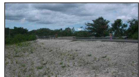
写真-18 補強工事を行った道路
