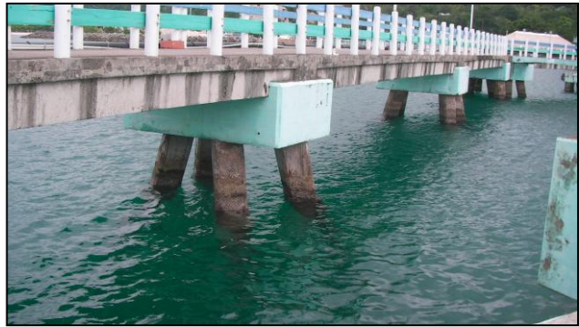
写真-21 杭の状況
