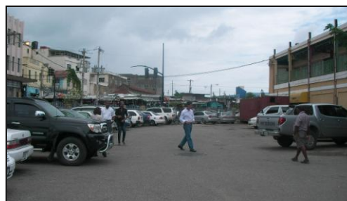
写真-11 施設上部の利用(駐車場)
