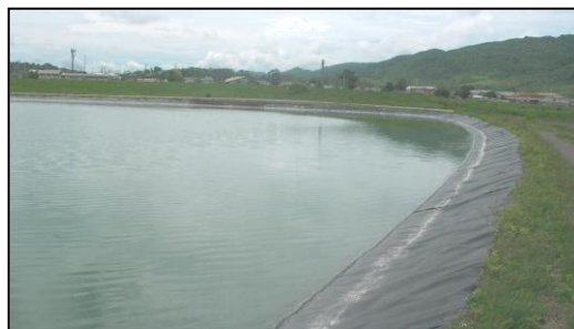
写真-2 処理施設の状況(処理用沈殿池)
