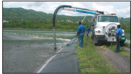
写真-16 廃水安定池の清掃
