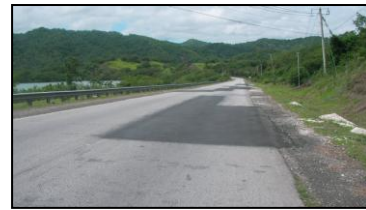
写真-9 道路修繕の状況
