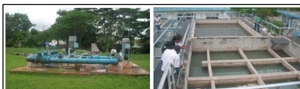
写真-3 ログウッド浄水場の様子
