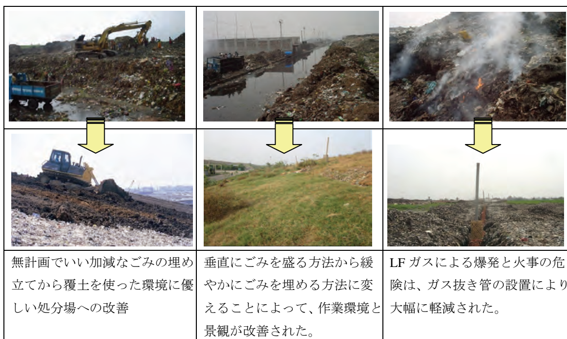
図 4.5-1 マトワイル既存処分場のオープンダンピングから衛生理立てへの改善
