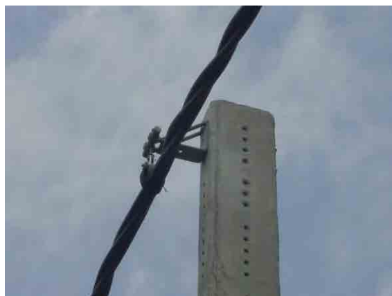
図 11-9 ラック金物で支持されたケーブル
