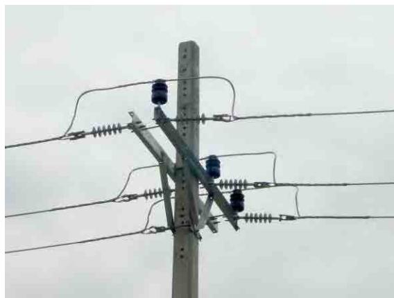
図 11-10 碍子（ピン碍子は磁器製、耐張碍子はポリマー製）
