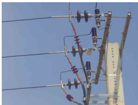
図 11-19 避雷器（ケーブルヘッド保護用）
