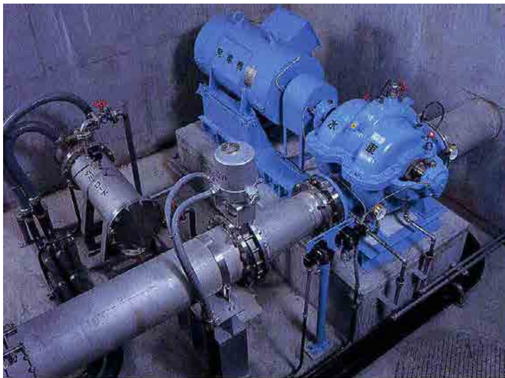
図 10-16 ポンプ逆転水車概観（両吸込み単段渦巻き形）
