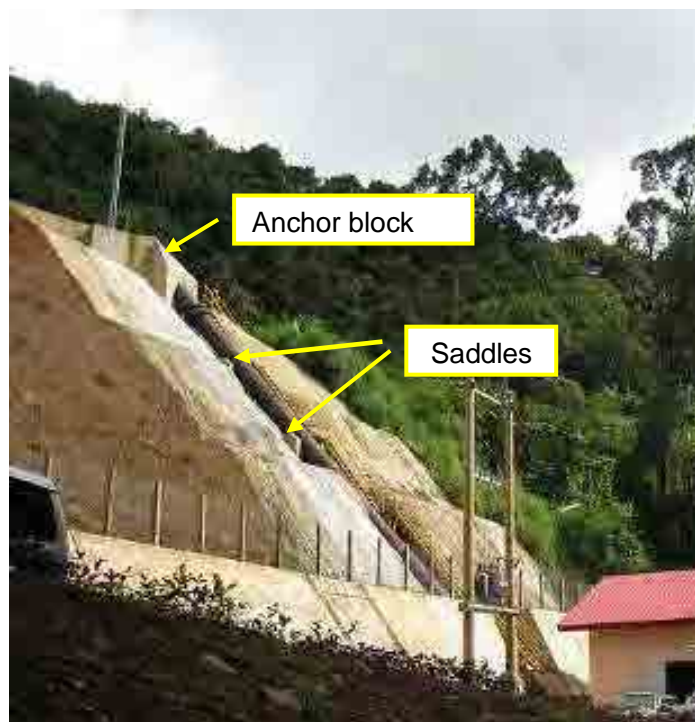
図 9-13 水圧管路の例
