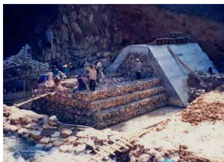
図 9-2 コンクリート補強布団かごダム
